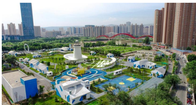
某市污水处理厂建成后实景照片
